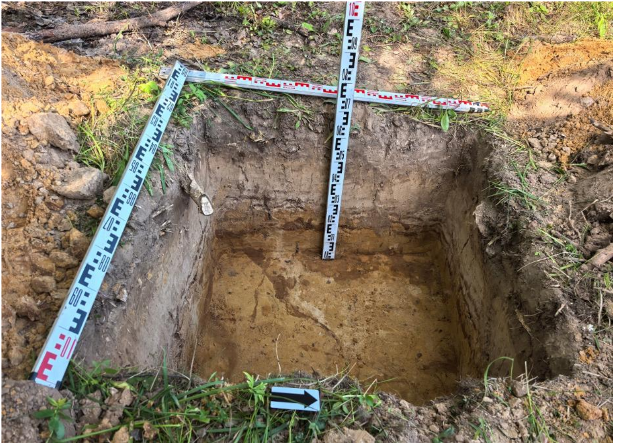
Илл. 16. «Газопровод давлением до 1,2 МПа» Шурф 1. Прокопка и зачистка материка. Вид с В.
