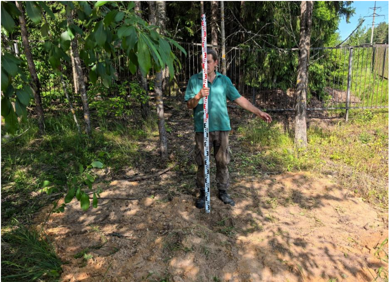
Илл. 17. «Газопровод давлением до 1,2 МПа» Шурф 1. Рекультивация. Вид с В.
