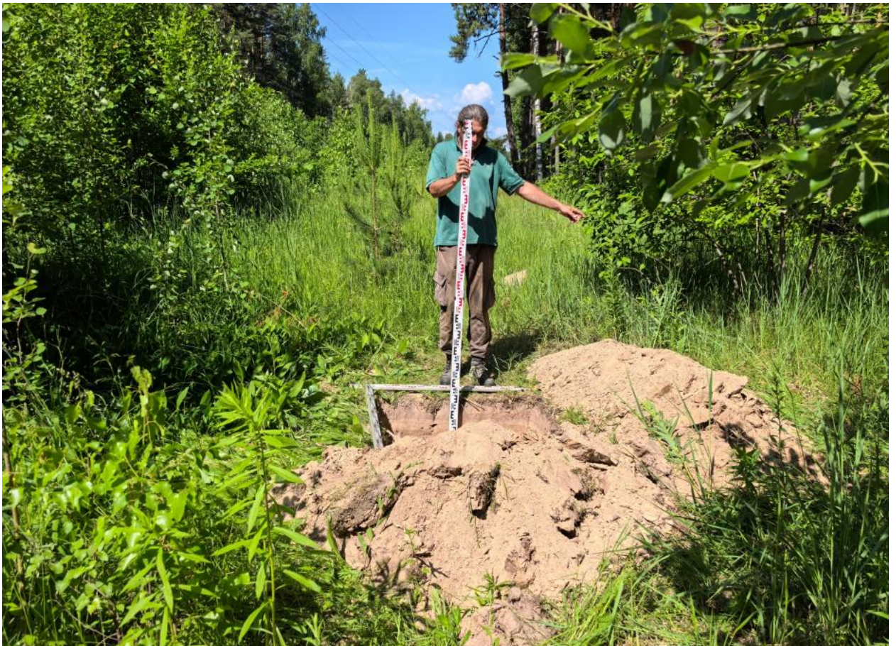
Илл. 19. «Газопровод давлением до 1,2 МПа» Раскопанный Шурф 2. Вид с В.
