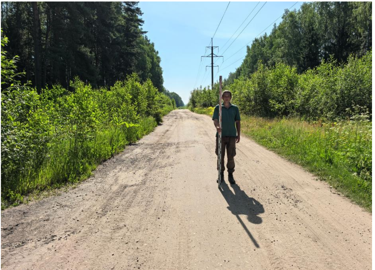
Илл. 9. «Газопровод давлением до 1,2 МПа» Точка фотофиксации 2. Вид с ЗСЗ.
