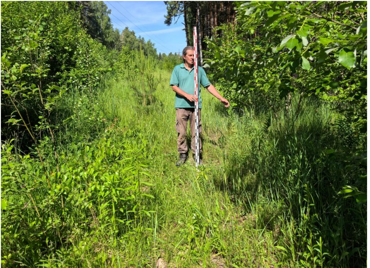
Илл. 18. «Газопровод давлением до 1,2 МПа» Шурф 2 до начала работ. Вид с В.
