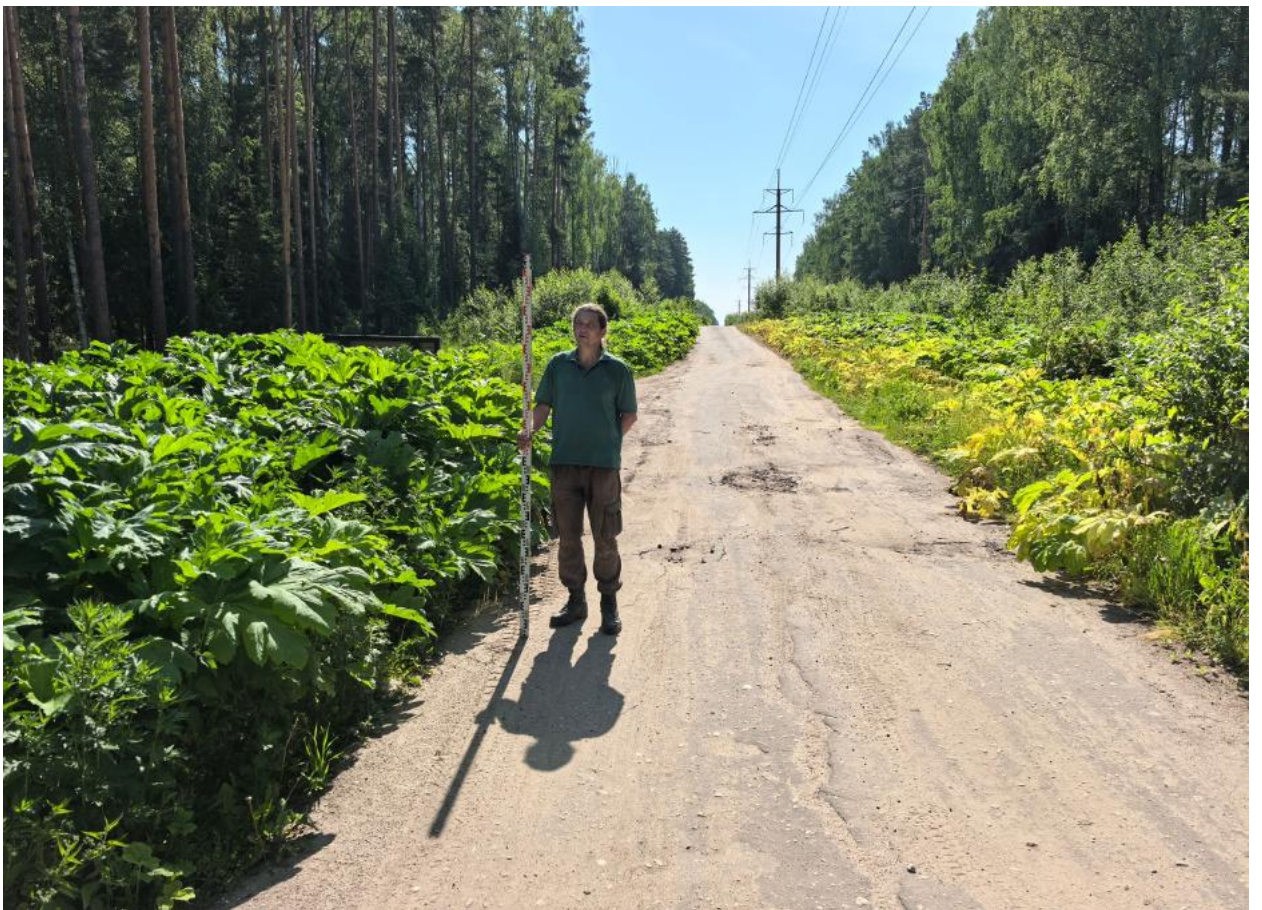
Илл. 11. «Газопровод давлением до 1,2 МПа» Точка фотофиксации 3. Вид с ЗСЗ.
