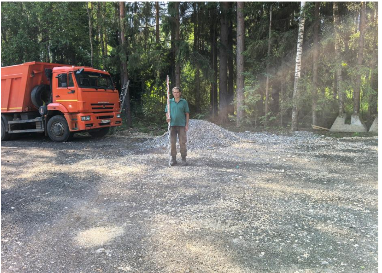
Илл. 13. «Газопровод давлением до 1,2 МПа» Точка фотофиксации 4. Вид с ССЗ.
