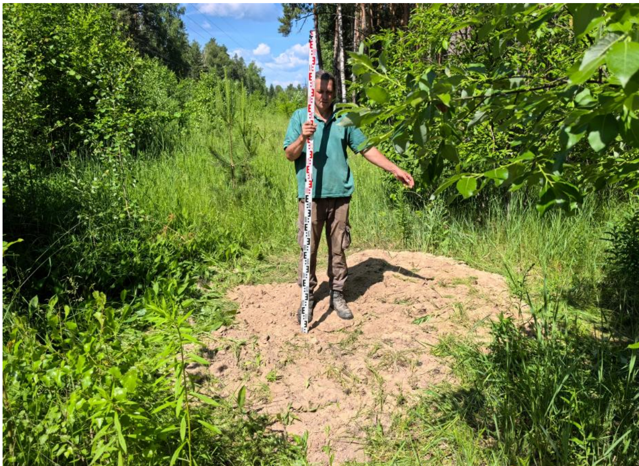
Илл. 21. «Газопровод давлением до 1,2 МПа» Шурф 2. Рекультивация. Вид с В.
