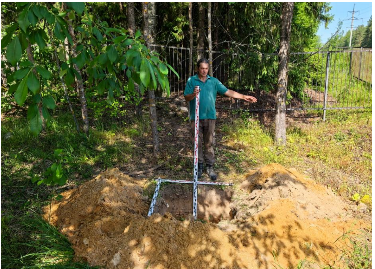
Илл. 15. «Газопровод давлением до 1,2 МПа» Раскопанный Шурф 1. Вид с В.
