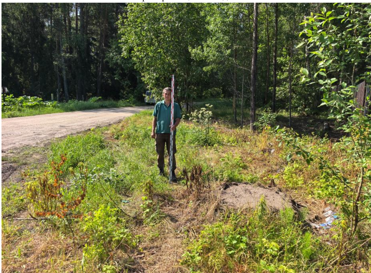
Илл. 7. «Газопровод давлением до 1,2 МПа» Точка фотофиксации 1. Вид с С.
